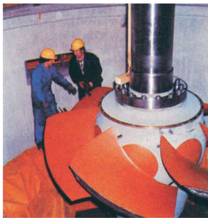
20.2 Laufrad einer Kaplan-turbine in einem Kraftwerk
