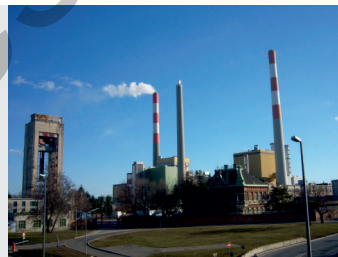
Kraftwerk Simmering – größtes Wärmekraftwerk Österreichs
