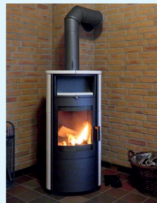
13.3. Ein geeigneter Schornstein ist auch für die gute Funktion eines Kaminofens Voraussetzung. Zughöhen von über 6 m sind vorteilhaft.
