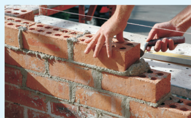
11.4. Luftkammern in den Ziegeln bewirken eine gute Wärmedämmung.
