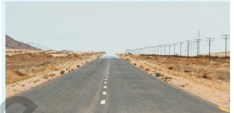
15.2. Der Asphalt wird stärker erwärmt als die Umgebung, denn seine dunkle Oberfläche absorbiert mehr Wärme. So wird auch die Luft über dem Asphalt stärker erwärmt als über der Vegetation und flimmert.
