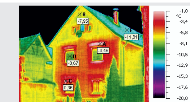
Die gemessene Oberflächentemperatur ist am Dach mit -11,81\text{ °C} am geringsten, es ist am besten gedämmt.
