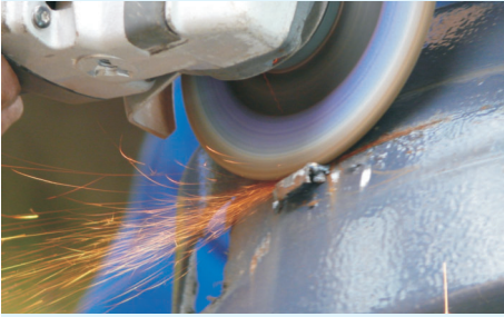
6.1. Metall erwärmt sich durch Reibung bei Bearbeitung mit der Trennscheibe.
